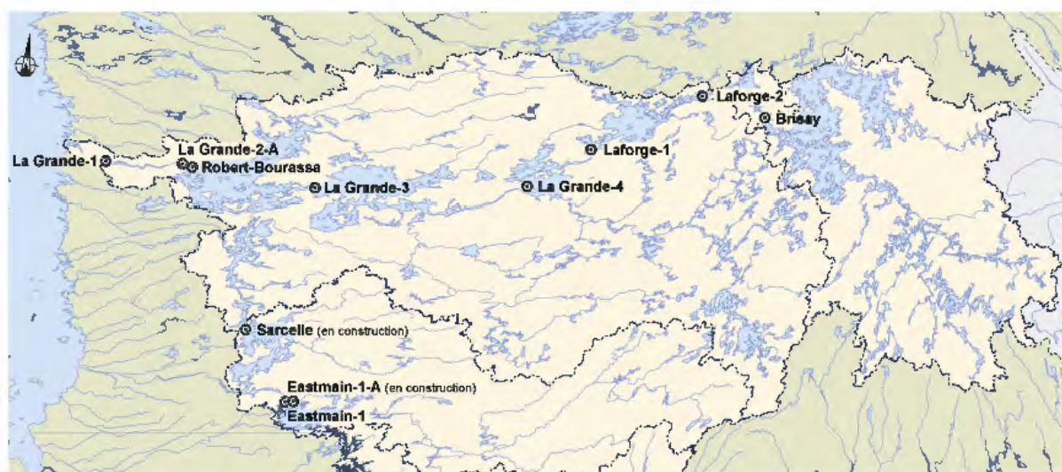
Figure 2.14 Centrales du Complexe hydroélectrique La Grande
