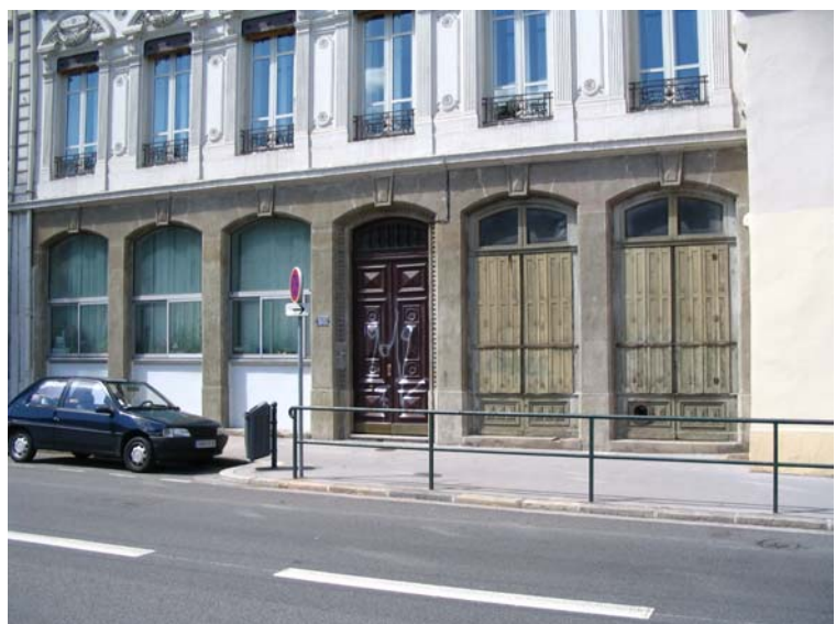
Le local du Comité Départemental de Spéléologie du Rhône au 28 quai Saint-Vincent – Lyon 1 er – en bord de Saône – les vieux volets en bois sont toujours fermés ! Cliché : Marcel Meyssonier .
