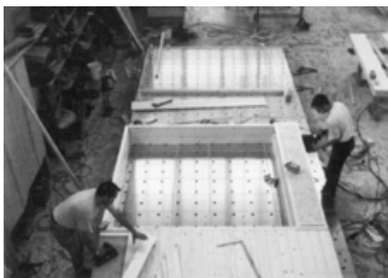
Fabrication d'un panneau en atelier (Prefabricated systems, Birkhauser Verlag AG, 2013, 133p).
