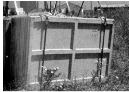
Les panneaux en béton armé sur site, prêt à être fixés à la structure en acier (Pondars, Valérie, « Maison Phénix, l'industrialisation au service de la qualité » in Les Cahiers Techniques du Bâtiment, n°193, 1998, pp 36-39).
