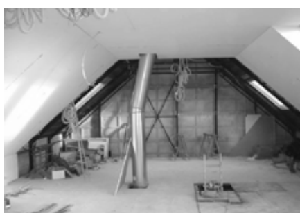
12 octobre 2008 : Couverture posée, le second œuvre commence.
