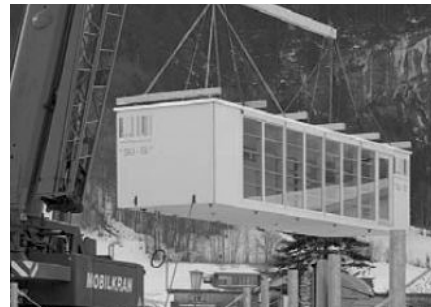
Positionnement final sur site de la maison Su-Si (Martinez, Ivan, « l'exception culturelle du Vorarlberg », D'Architecture , n°130, 2003, pp. 24-26).
