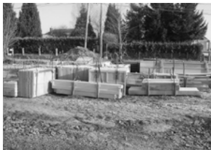
08 janvier 2008 : Réception des éléments préfabriqués.
