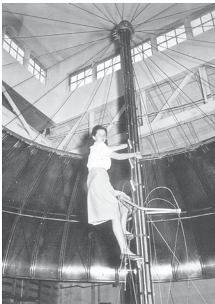
Ci-dessous : Intérieur de la Wichita House, lors du montage et une fois terminé (Gorman, Michael-John, Buckminster Fuller: Designing for mobility , New York, Skira, 2005, 208p).
