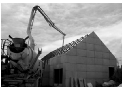
13 juin 2008 : Un camion-malaxeur permet de couler la dalle haute.
