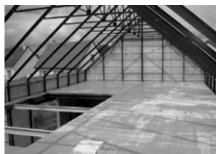
14 juin 2008 : La dalle de sol est prête à accueillir un revêtement.
