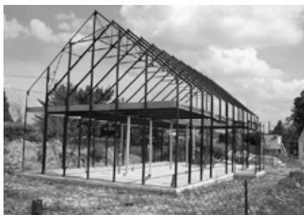
21 mai 2008 : Montage de la structure principale fini.
