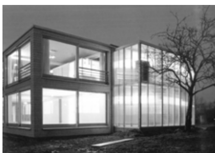
Ci-dessus et ci-dessous : Les nombreux panneaux de remplissage permettent d'adapter le système préfabriqué au site tout en attribuant une qualité lumineuse suffisante pour les espaces intérieurs (Knaack, Ulrich, Chung-Klatte, Sharon, Hasselbach, Reinhard, Prefabricated systems, Birkhauser Verlag AG, 2013, 133p).
