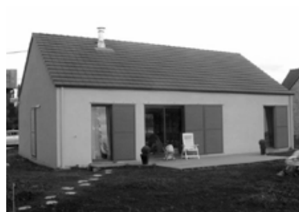
22 décembre 2008 : Une construction saine, mais banale.
