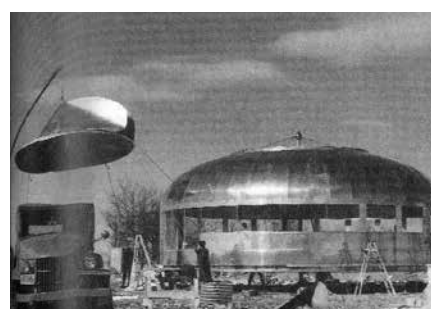
Ci-dessus : Phases de montage de la Wichita House, de la mise en place des pilotes à la pose du volet de ventilation (Fuller, Buckminster, in Snyder, Robert, Richard Buckminster Fuller : Scénario pour une autobiographie, Paris, Image Moderne, 2004, 190p).
