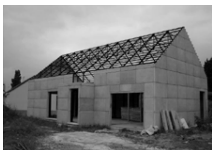
09 juin 2008 : Pose des panneaux en béton armé terminée.
