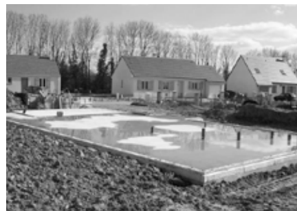
16 mars 2008 : Coulage en place de la dalle de sol.
