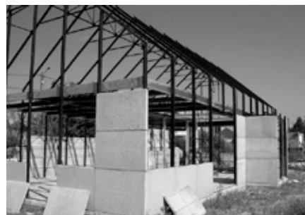
09 juin 2008 : Montage de la structure principale terminée.
