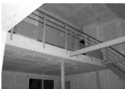
21 novembre 2008 : Pose des dernières parois en plâtres.
