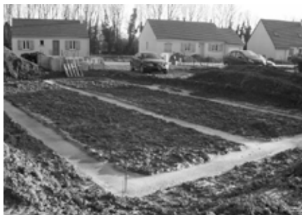
05 février 2008 : Mise en œuvre des longrines .
