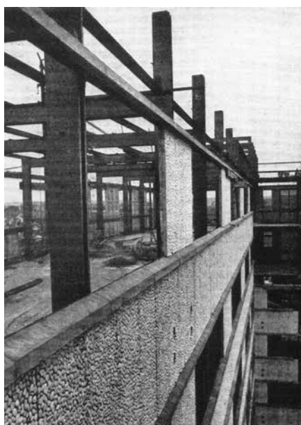
Ci-dessus : Cité de la Muette de Drancy, les éléments préfabriqués lourds en béton sont disposés sur la structure métallique des tours ( l'Architecture d'aujourd'hui n°4, 1945, pp. 11).
