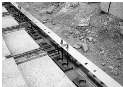
18 mars 2008 : Mise en place du chainage .
