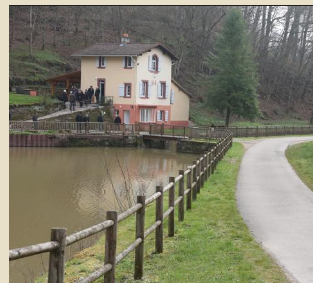
400 000 € de travaux sont prévus dans la vallée des Éclusiers. Photo archives Laurent MAMI
