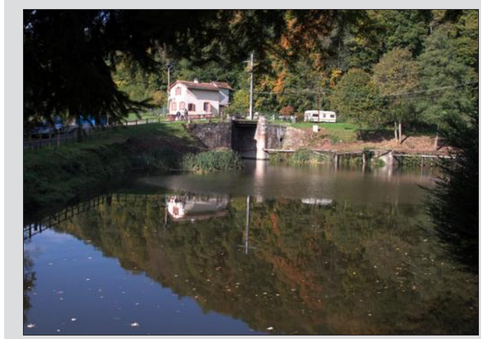
L'intercommunalité veut poursuivre les travaux de restauration dans la vallée des Éclusiers. Photo archives RL
