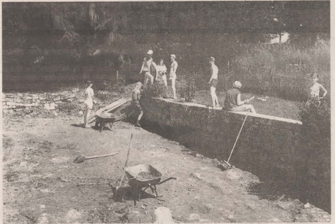
Le lavoir à moutons déblayé
