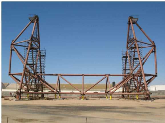
Fig. 2.15: Monture de H.E.S.S. II en cours de construction. Crédits : Collaboration H.E.S.S.
