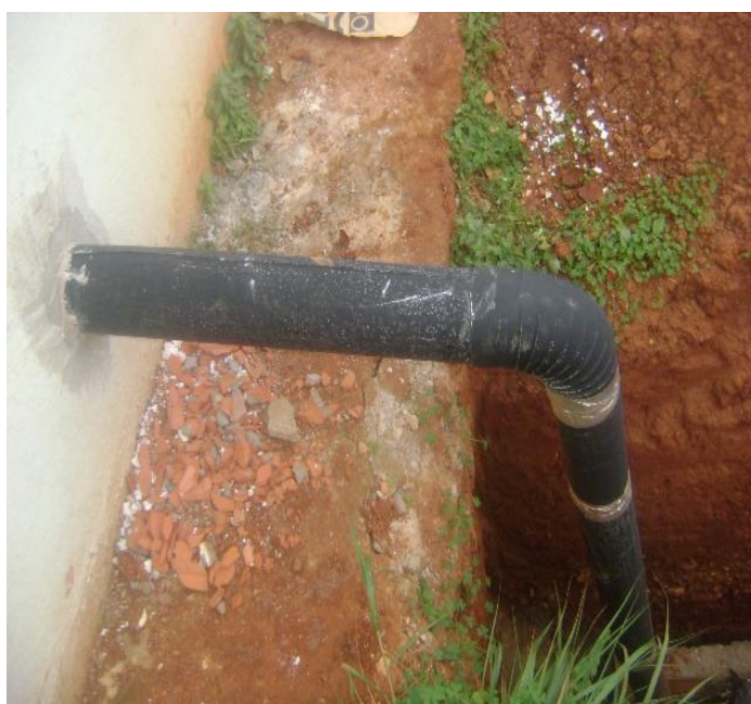
Figure IV-11 : Intégration de l'ECAS dans la cellule d'essai (Tennah, 2013)
