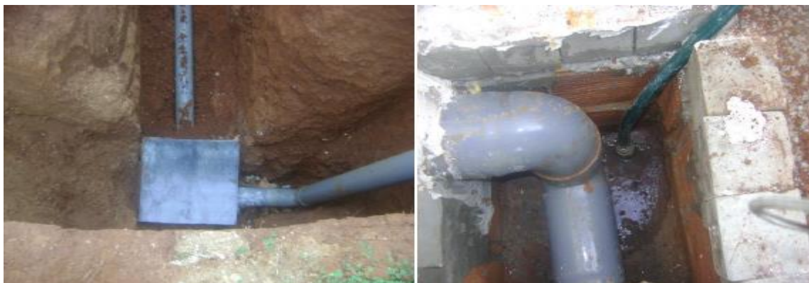
Figure IV-10 : Système d'évacuation de condensat (Tennah, 2013)
