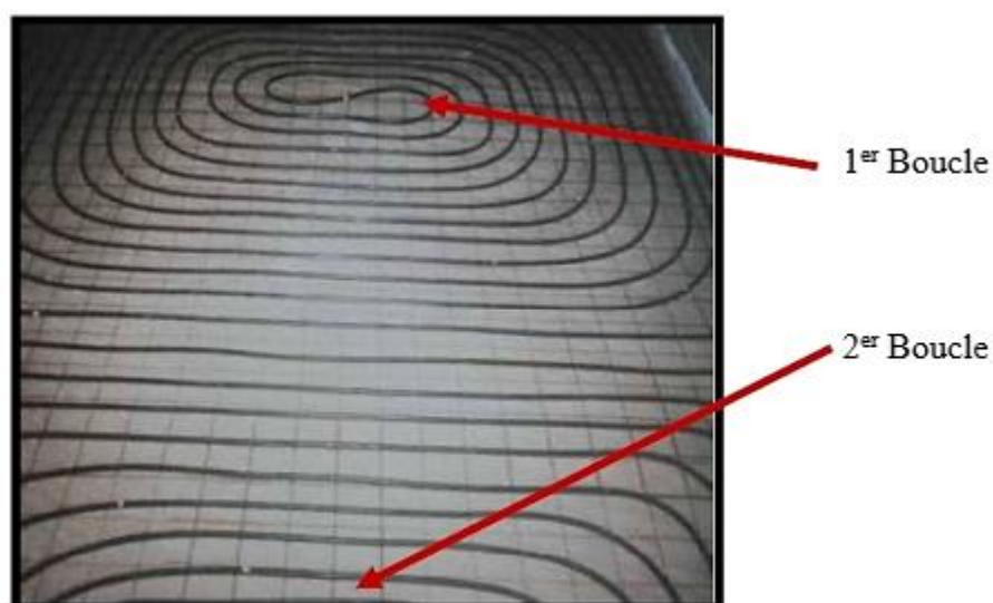
Figure IV-5 : Circuit hydraulique en deux boucles (Menhoudj, 2008)
