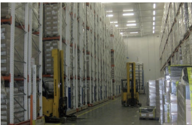
Dans l'entrepôt à -20°C, le rack mobile distribue 6 000 palettes sur 2 000 m 2 .
