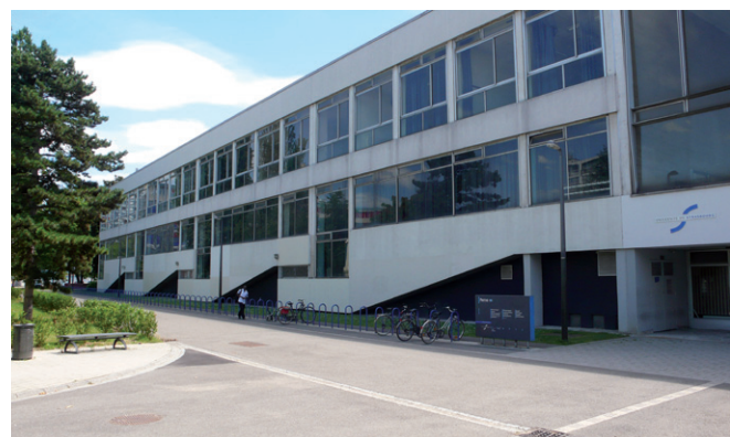
Pierre Vivien et Pierre Eldin Bâtiment Le Patio, ancienne faculté des Lettres et Sciences Humaines
