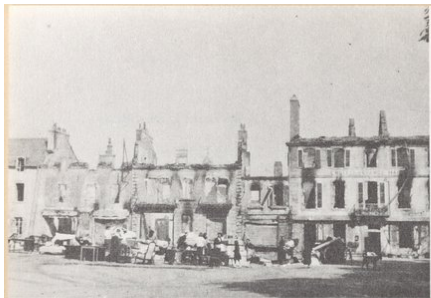
Ruines à Lesneven. On essaie de sauver ce qui peut l'être.
