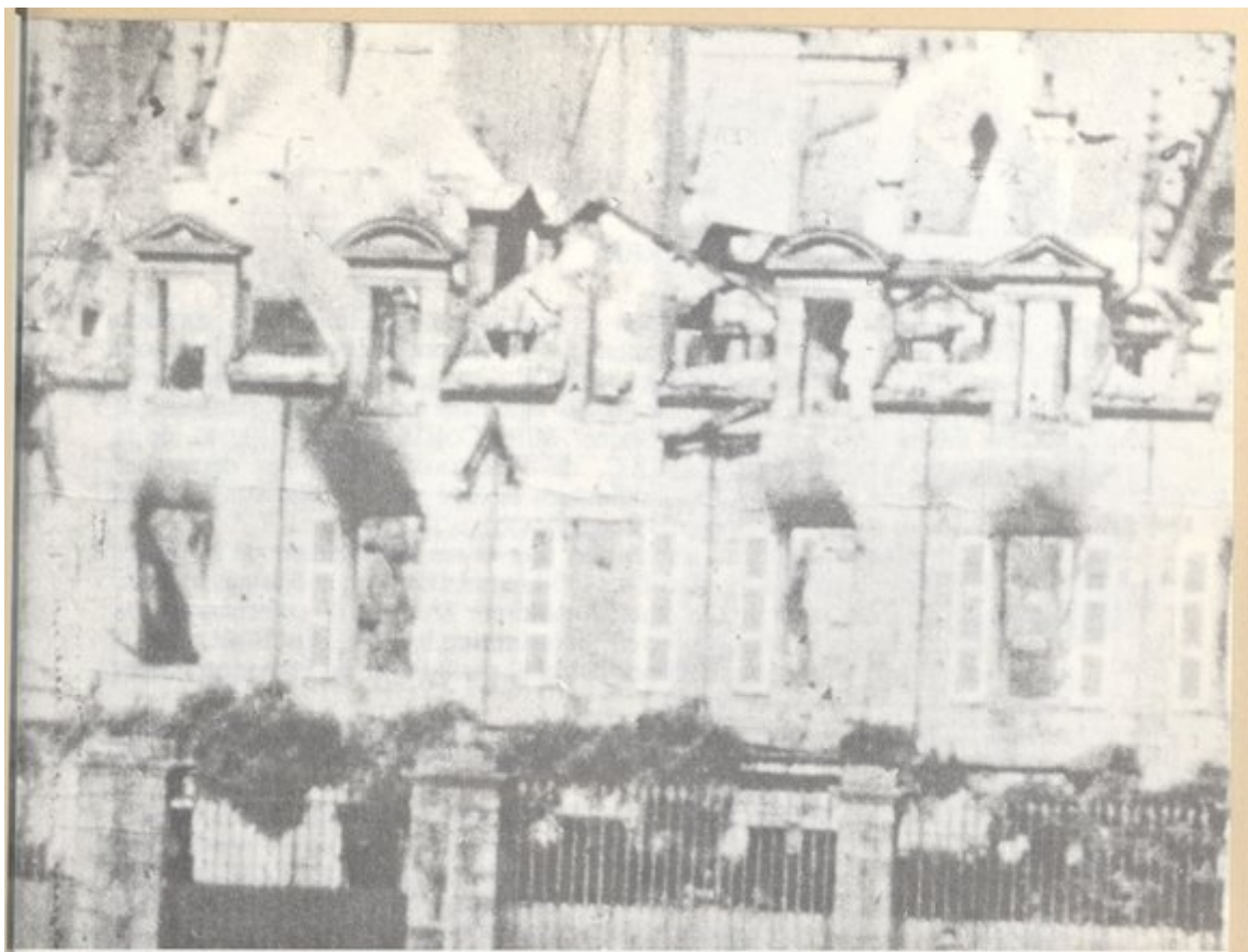
Quimper : Ruines de l'Hôtel du Préfet, incendié le 5 août 1944.
