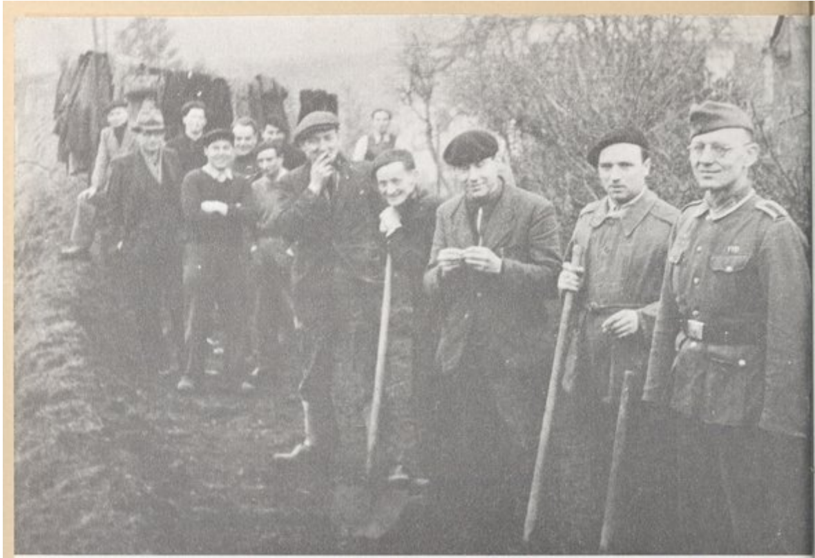
Ultimes travaux de fortification. – Requis quimpérois.
