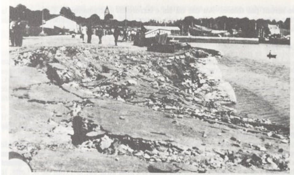
Concarneau, 25 août 1944 : Dégâts causés aux quais par l'explosion de deux mines allemandes.
