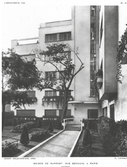
Immeuble d'habitation, rue Méchain, Paris 14 e Architecte: Robert Mallet-Stevens
