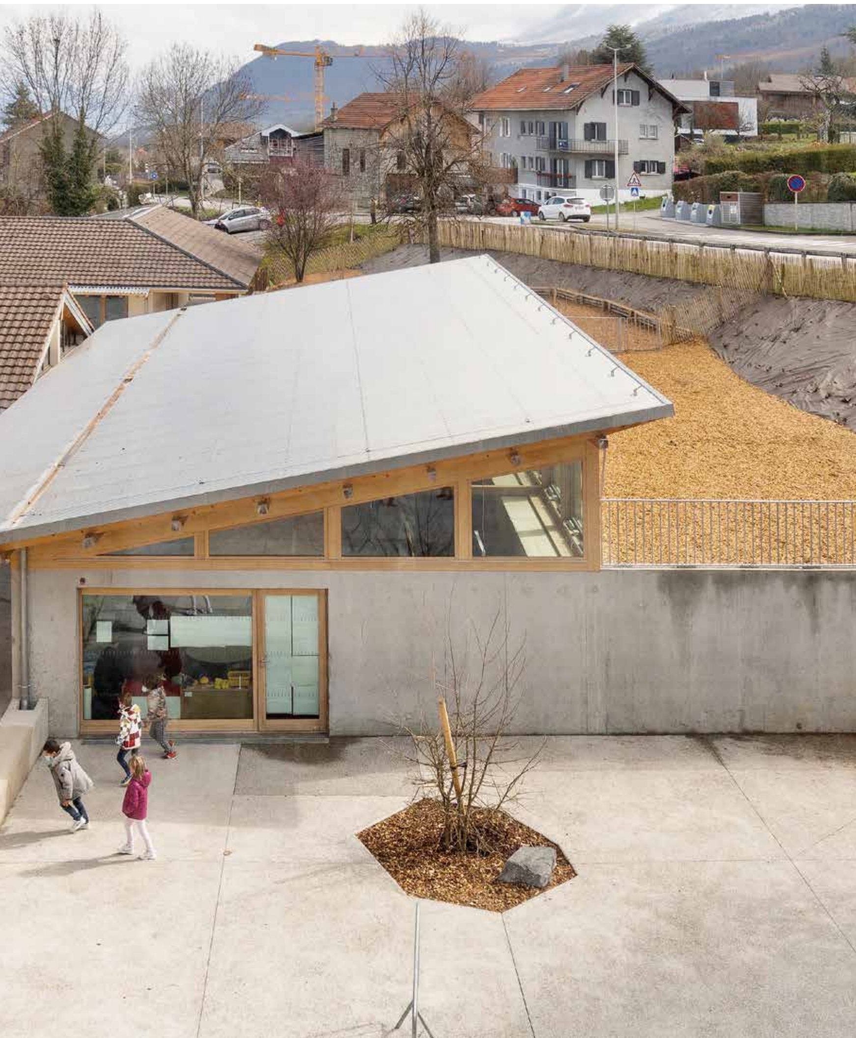
Les constructions neuves, repérables à leurs toitures en tôles ondulées d'aluminium, s'adaptent au gabarit des bâtiments déjà en place
