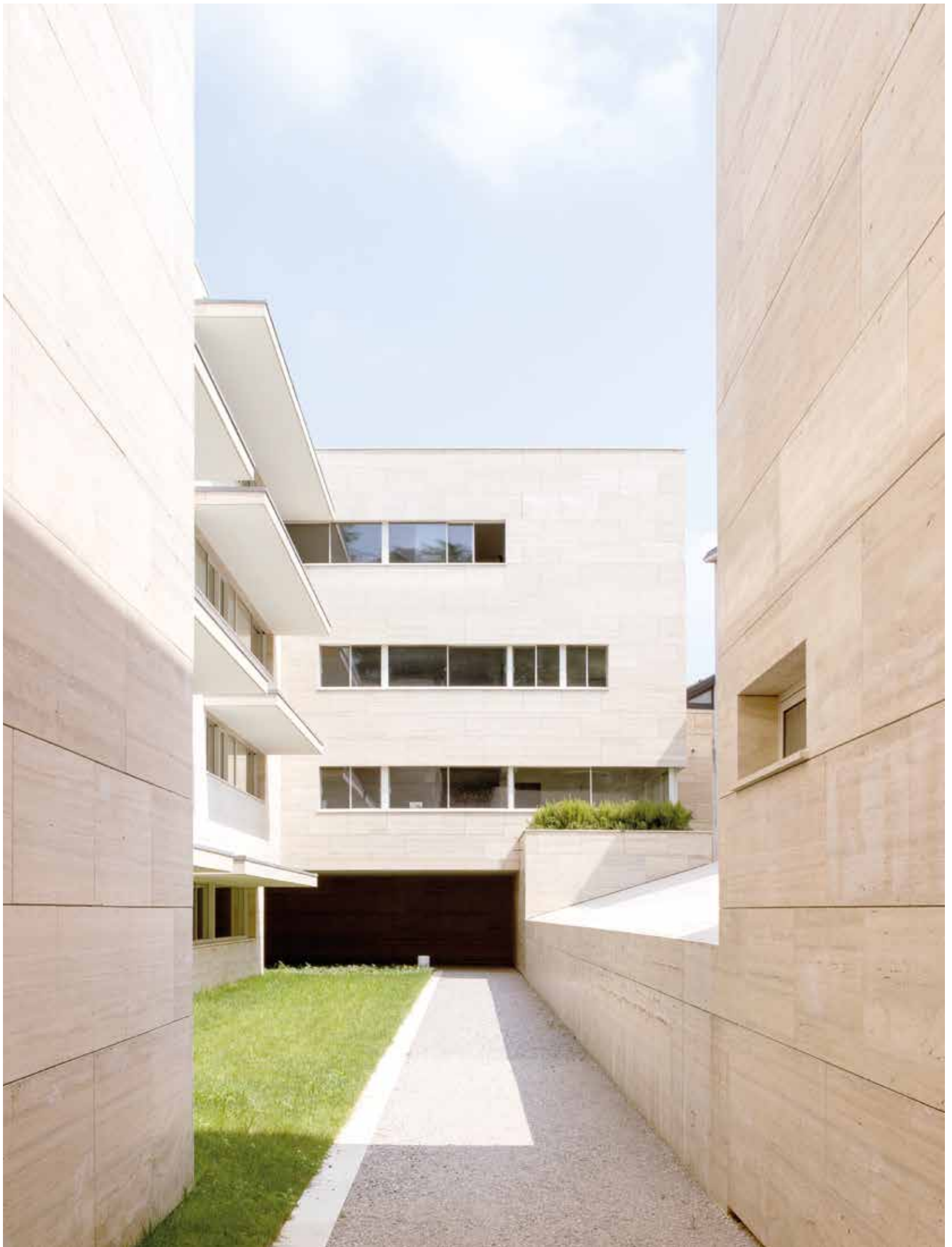
Le projet reproduit la traditionnelle cour lombarde et les ruelles de la ville antique
