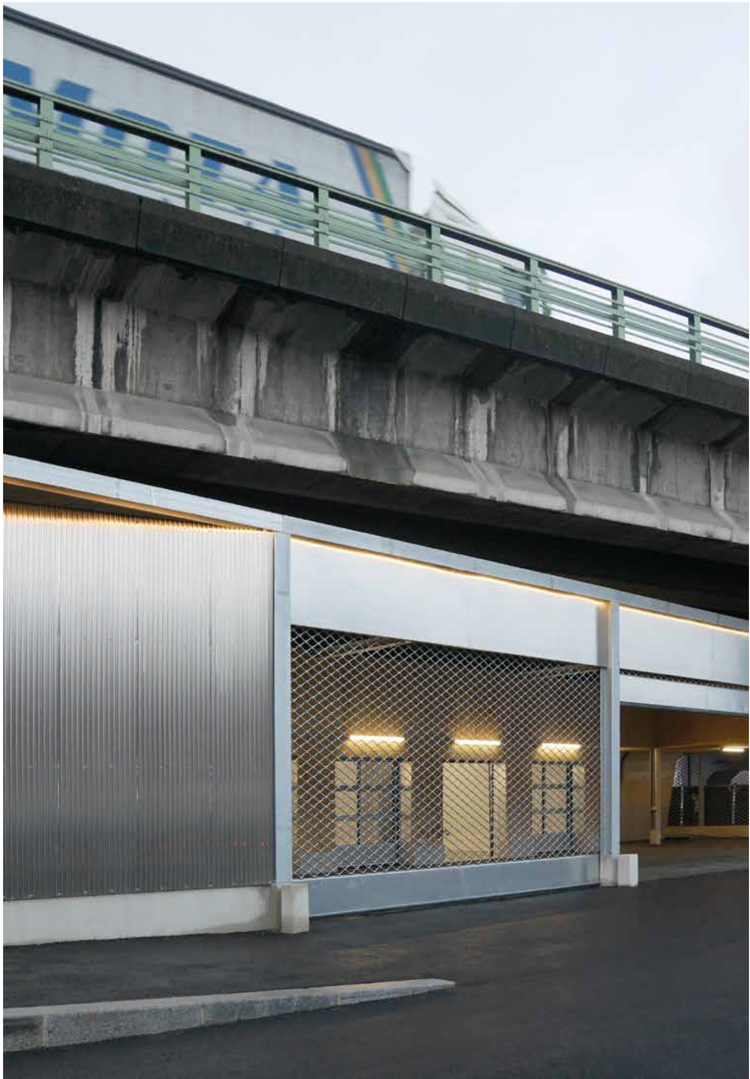
Sous le périphérique et au-dessus des tunnels, le bâtiment est connecté aux infrastructures de transports
