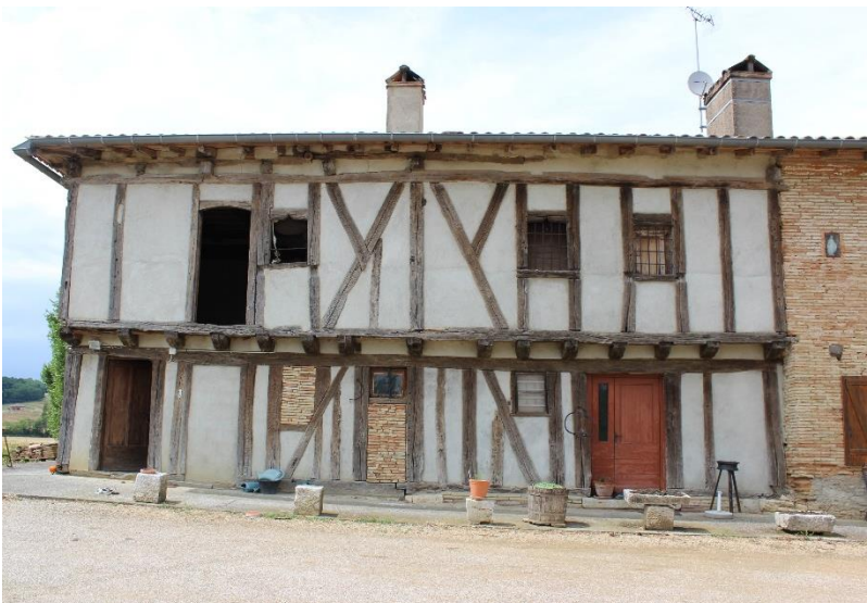
Ferme au Soulié en 2015, pan-de-bois en rez-de-chaussée et à l'étage.
