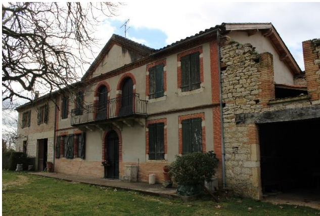
Ferme du Truc. L'organisation longitudinale de cette ferme comprend sous un même volume, une habitation, un chai et une grange-étable. La particularité de la construction réside dans la mise en valeur de la partie centrale sous un fronton triangulaire.
