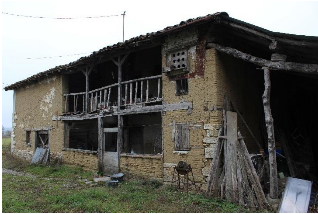
Ferme de Griffoulet. Unique « maison-ferme » en adobe avec porche et galerie en bois conservée.
