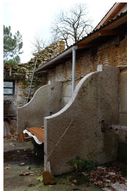
Bat-flancs monolithes dans l'étable au Truc. Chacun mesure 2,40 m de hauteur ; 1,86 m de largeur ; 17 cm d'épaisseur, avec un ancrage d'environ 50 cm dans le sol.
