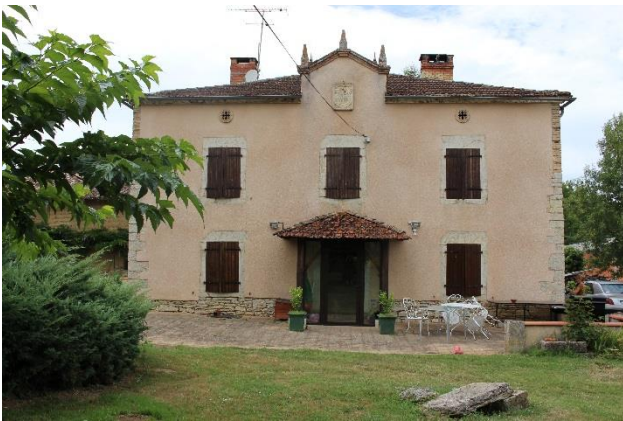
Logis à La Bloyne. La distribution est identique au logis simple, seul un étage a été ajouté et une lucarne centrale met en exergue la travée centrale.
