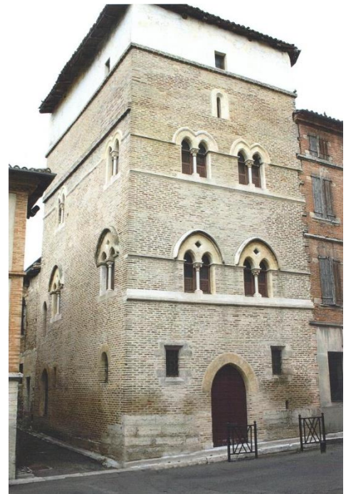
Tour d'Arles. Etat après les restaurations de 1999. Photographie Pierre Garrigou-Grandchamp. Comme à la tour de la Taverne, des baies géminées se trouvent au premier et au deuxième niveau.
