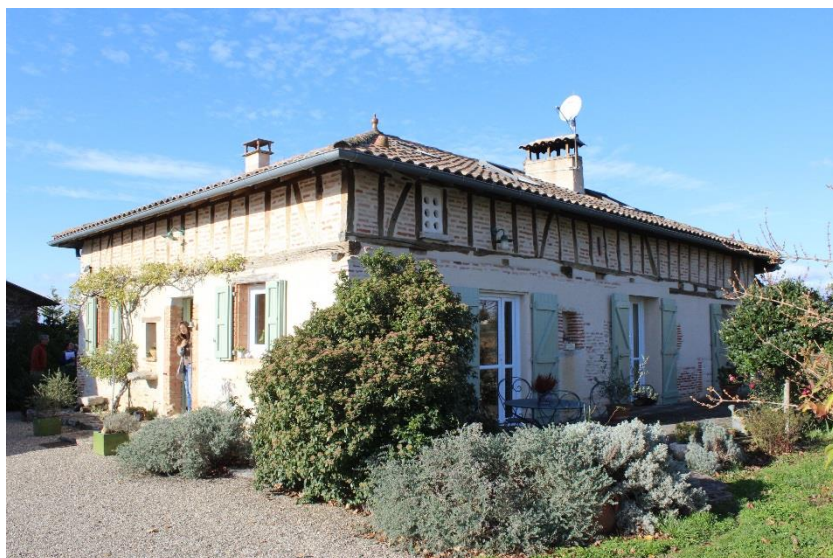
Ferme à Saint-Pierre de L'Herm vraisemblablement construite au XVIe ou XVIIIe siècle en terre massive et en pan-de-bois.
