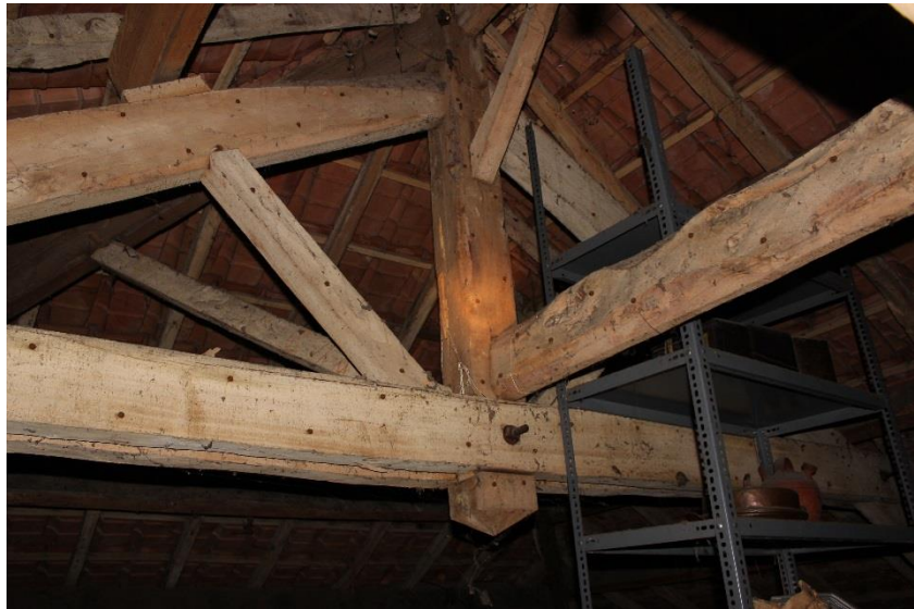
Maison de Romain Delmas, bvd. du Général Leclerc, vue de la charpente.
