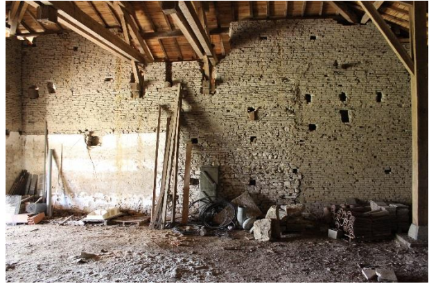
Grange-étable à Gouzes, reconstruite sur une précédente en partie en pierre. Les vestiges englobés sont visibles au centre du mur reconstruit en adobe.
