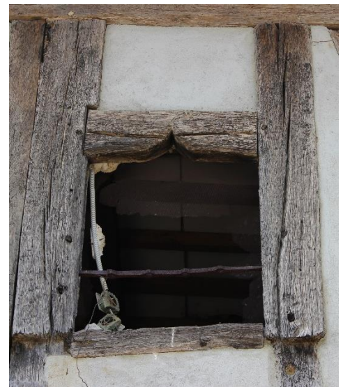
Détail d'une ouverture avec un linteau en accolade.
