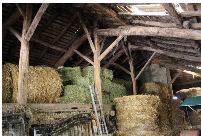
Grange-étable à deux travées à Piboul. Le mur-bahut qui sépare la grange de l'étable reçoit les poteaux de la charpente. Les essences de bois communément employées pour les charpentes sont le peuplier et le chêne.
