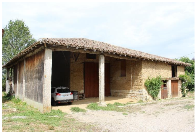
Grange-étable à La Bloyne. Association de la brique de terre crue au calcaire pour le soubassement et les piliers monolithes. Sur un pilier est gravé : « Gabriel Marre 1880 ».
