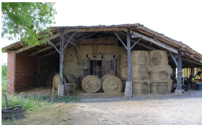
Grange-étable à Roches. L'auvent sur poteaux de bois permet le stockage du matériel ou du foin et protège ici la façade en brique de terre crue.
