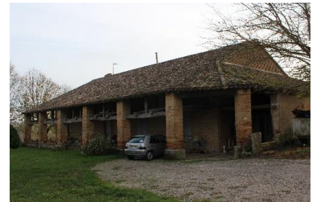
Castel-bas, logis, vue depuis le nord-ouest.
