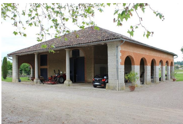
Grange-étable à Roucou. Elle est révélatrice de la parfaite maîtrise du système constructif alliant la brique crue à la brique cuite avec l'introduction d'éléments exceptionnels en pierre de taille calcaire.
