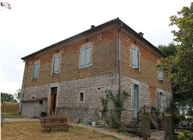
Logis à Roubis. Calcaire en rez-de-chaussée et brique cuite de deux couleurs différentes à l'étage. Les murs intérieurs sont en briques de terre crue.
