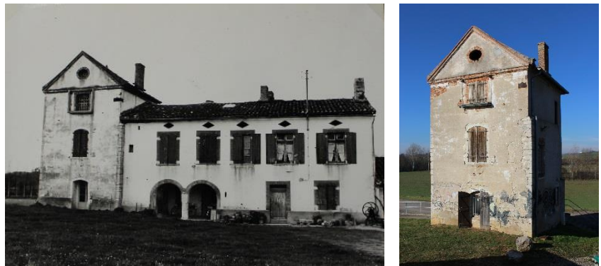
Ferme à Gouzes en partie détruite suite au passage de la déviation en 1981. Le pigeonnier a été épargné. Photographie d'Albert Ferlin, 1970.
