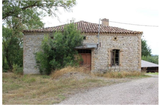
Logis à Pech-Souqué. Construit à la fin du XIXe siècle, ce logis présente une enveloppe en calcaire et des murs intérieurs en adobe. Les encadrements des ouvertures et les chaînes d'angle harpées, en brique, associés à une maçonnerie en moellon de calcaire est une pratique constructive caractéristique de cette période (fin du XIXe siècle et début du XXe siècle).
