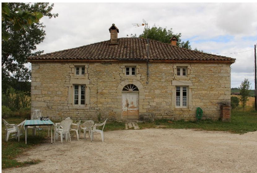
Logis à Belfil. Sous une enveloppe en calcaire, les murs intérieurs sont en adobe.
