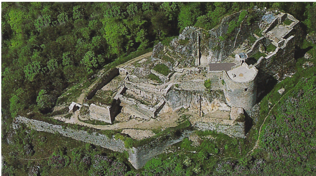
Fig. 2 : le château vu du sud. Photo aérienne R. Goguey, 2000.
