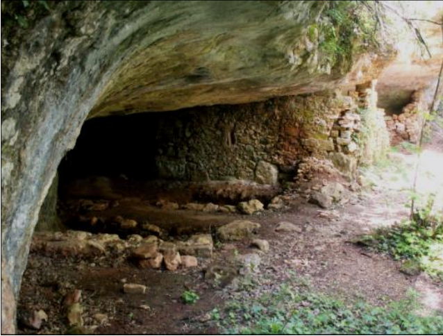
Fig. 7 : On distingue les fouilles réalisées par l'ASER. Au centre, une grande structure maçonnée et crépie à l'intérieur.
