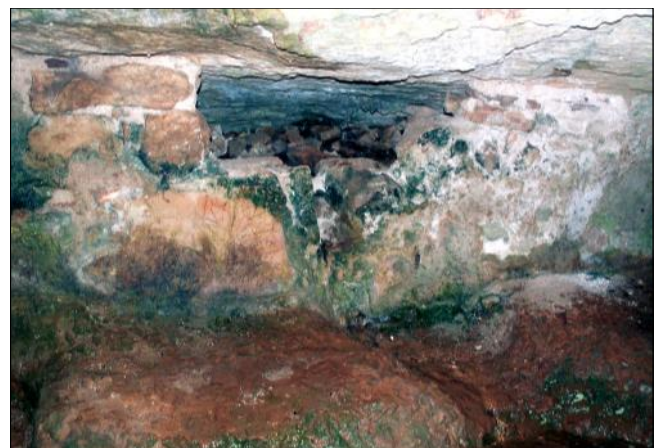
Fig. 12 : Le mur d'accès à la citerne et son trop plein. On voit les pierres qui comblent la citerne.
