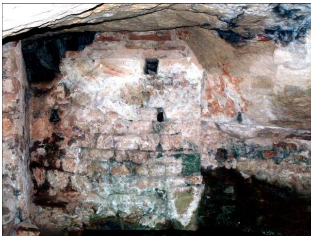
Fig. 10 : Le 17 décembre 2008, après les pluies, il y a 20 cm d'eau au pied du mur de la fresque. Les regards ne sont pas humides, mais à droite, le mur de la citerne est détrempé.
