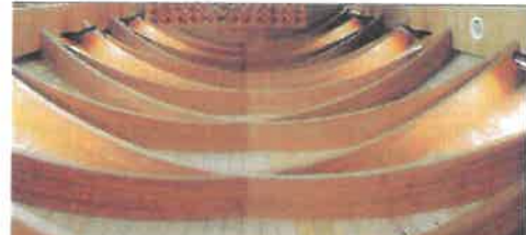
Structure en lamelle-collé réalisée par l'entreprise Haas Weisrock pour la Base de loisirs de Xertigny (Photo : Nicolas Weisbaugh-Weisbaugh pour « Le lamelle de hêtre en lice pc les Tropéales Eurobois »)
