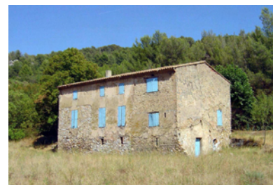
Pont de Joux
