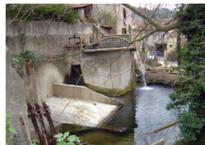
Ancien site de moulin à Pont de Joux
