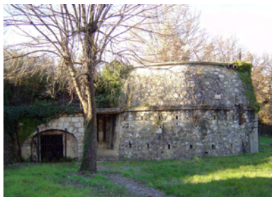
Ancienne entrée de mine de Lignite (Saint Zacharie)
