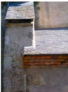
Toit en ardoise, mur calcaire et corniche de brique
