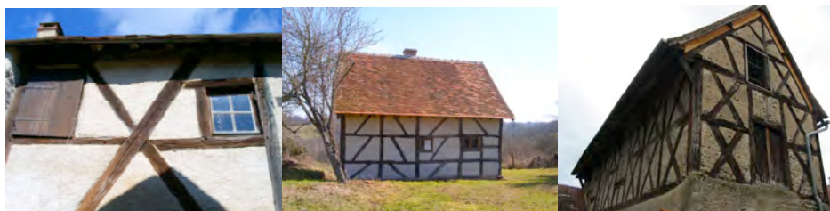
Maison à colombages (torchis sur latis), Chatelperron, Jaligny-sur-Besbre, Châtelerron. © Etienne Fradin, Olivier Munos
