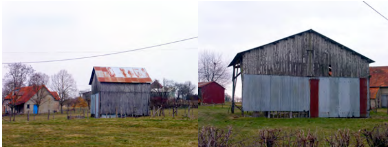
Des rénovations dans un souci d'utilité : perte de caractère entre Chavroches et Jaligny-sur-Besbre © Etienne Fradin
