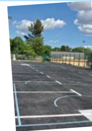
Le montant des travaux a été pris en charge à hauteur de 38 % par la Communauté du Pays d'Aix.
