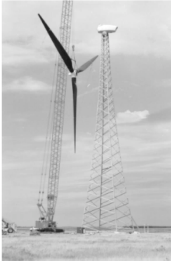
Figure 4 : Tour en treillis
