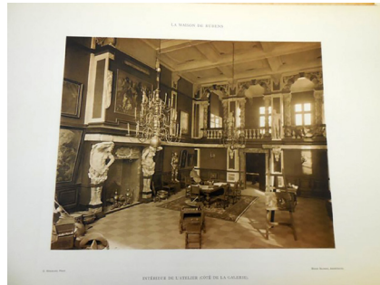
Fig. 9 : Photo de l'intérieur de l'atelier côté de la galerie.
