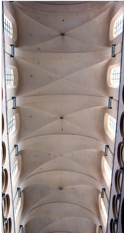
Fig. 4 : Voûte de la nef (cl. L.L.).
