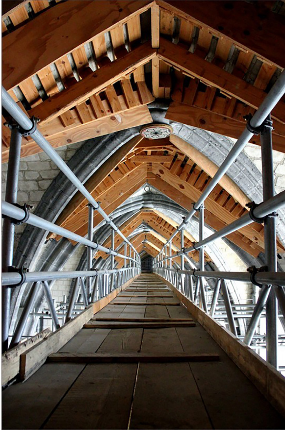
Fig. 17 : Squelette de bois créé pour maintenir les voûtes (d. L.L.).
