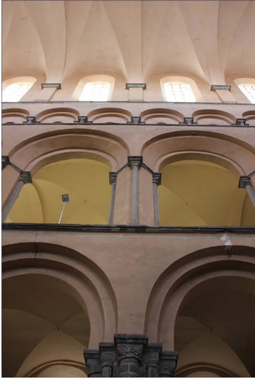
Fig. 5 : Élévation de la nef (cl. L.L.).
