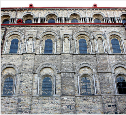
Fig. 7 : Élévation extérieure de la nef (cl. L. L.).
