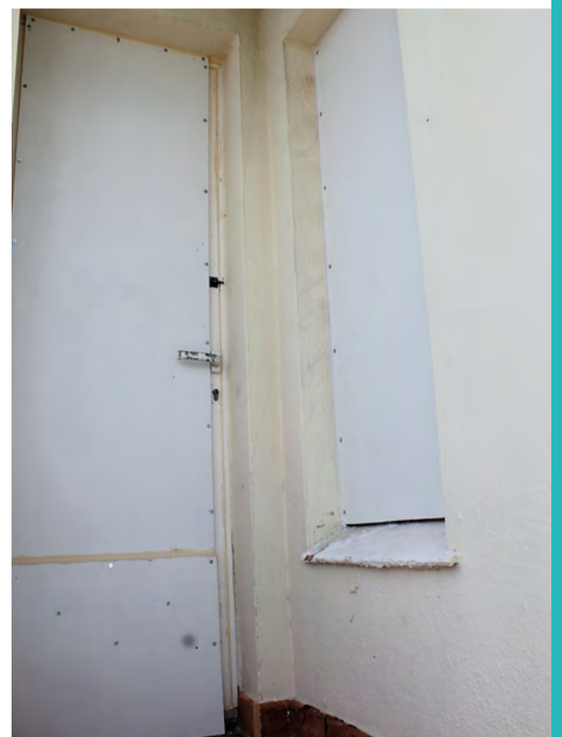
CONSOLIDEZ LES PORTES ET FENÊTRES PAR DES PANNEAUX EN BOIS
