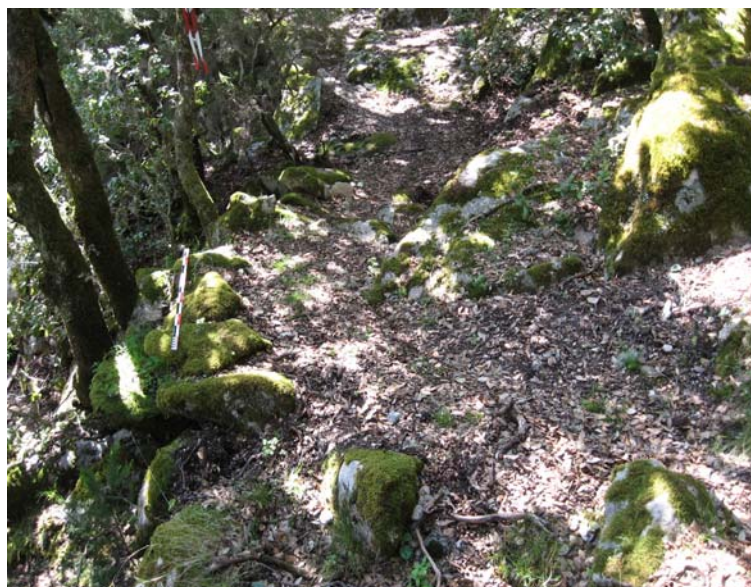
Figure 477 – Soutènement du C.A. A (photo S. Delvaux)
