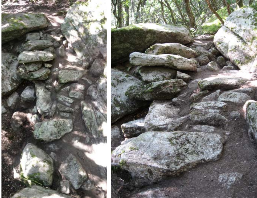
Figures 482a et 482b – Rampe C.A. B vue depuis le haut (à gauche) et depuis le bas (à droite) (photos S. Delvaux)
