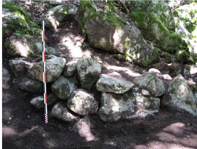
Figure 480 – Mur de soutènement formant le premier lacet du C.A. A2 (photo S. Delvaux)
