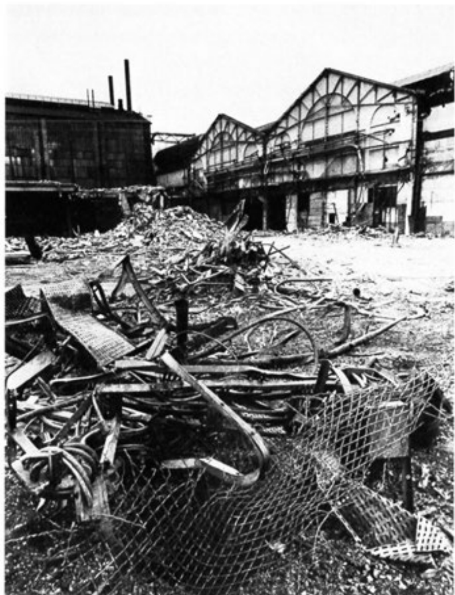
Juin 1976, démolitions en cours.
