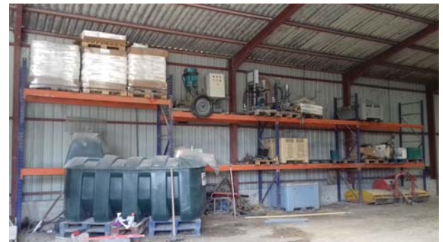
2- Sécurisation du matériel sur racks – DREAL Auvergne-Rhône-Alpes
