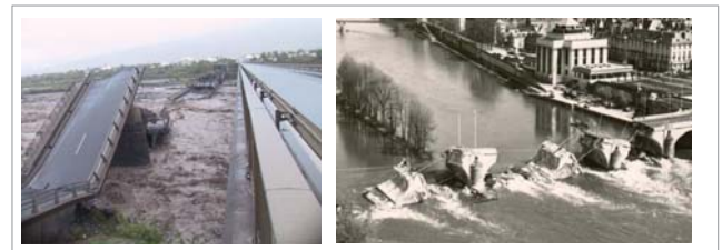
Exemples d'effondrements de ponts dus à l'affouillement des fondations : À gauche : le pont sur la rivière à la Réunion en 2007 (Source : Cerema) À droite : le pont Wilson à Tours en 1978 (Source : la Nouvelle République)
