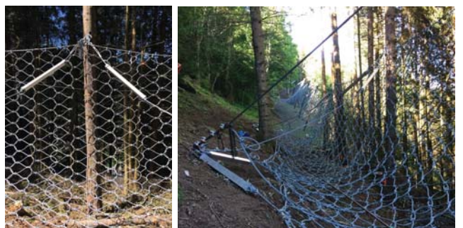
Exemple d'ouvrages 3000 kJ (NGE)
