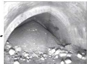
Cavité découverte par forage au sein d'une anomalie gravimétrique © GINGER CEBTP
