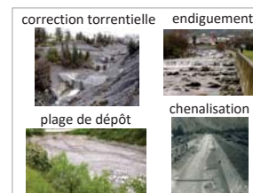
Ouvrages torrentiels : typologie et fonctions
