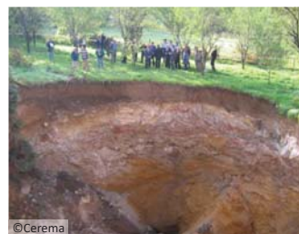
Effondrement du 23 janvier 2005 à Roquevaire (Bouches-du-Rhône - 13)
