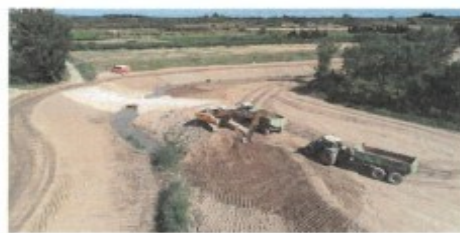
Travaux de suppression de digues défectives et renaturation du Briançon à Théziers (ci-dessus) - Prélèvement réalisé dans le cadre d'une étude sur les eaux souterraines (ci-contre)
