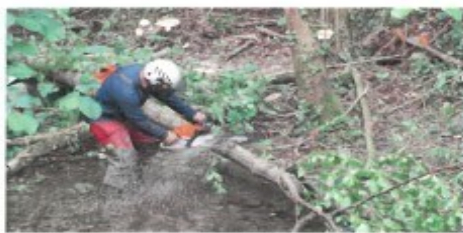
Travaux d'entretien de la rivière par l'équipe verte de l'EPTB Gardons : les végétaux susceptibles de faire obstacle à l'écoulement naturel du cours d'eau sont éliminés
