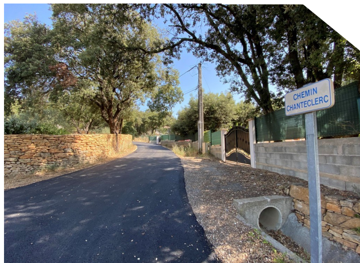
Revêtement et busage pluvial du Chemin Chanteclerc
