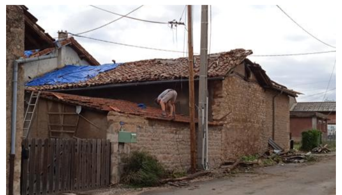
Les habitants prenaient rapidement en main l'opération déblaiement. Photo Guy Sautarel
