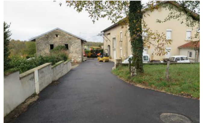
La réfection des routes, des travaux de saison.
