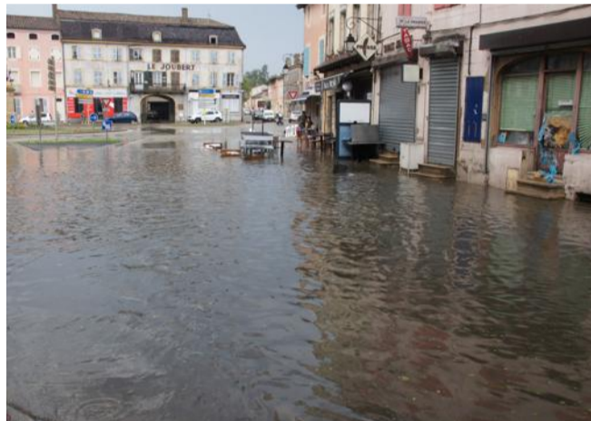
La rue de Lattre sous les eaux. Photo André Descottes
