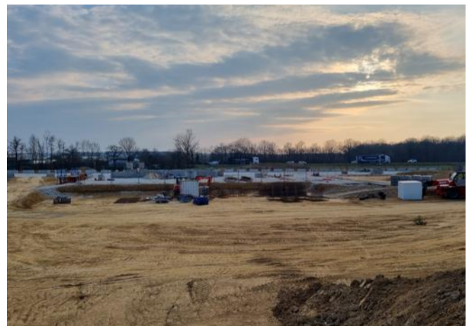
En mars, la plateforme de messagerie était en construction. Les travaux ont bien avancé et la plateforme devrait ouvrir en octobre prochain. Photo d'archives Pierre-Yves Royet
