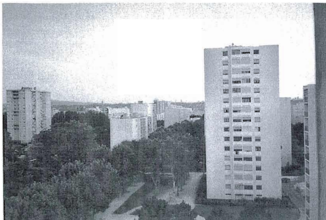
Figure 4.4 Verticalité du bâti (Mas-du-Taureau – Vaulx-en-Velin – Lyon – 69)
