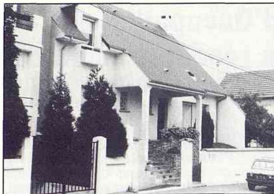
Construction neuve de pavillon (ci-dessus).
