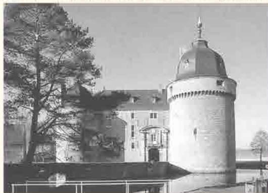
ROCHEFORT-Le château de Lavaux-Sainte-Anne.
