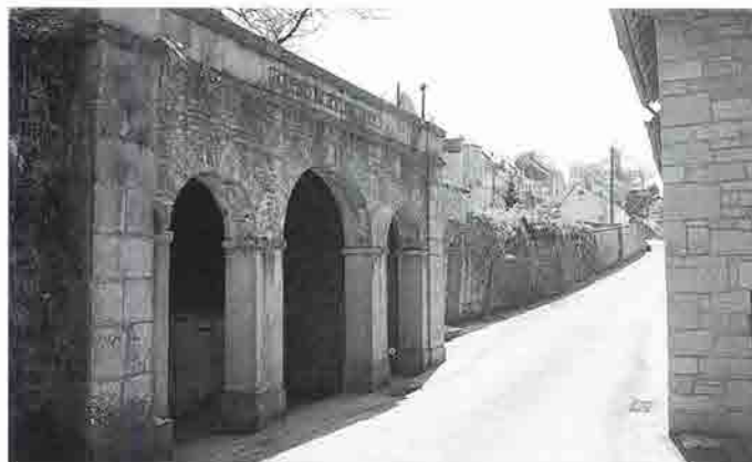
CHIMAY-Chimay, quartier de la Basse-ville. Cliché F. Dor, DPat. © MRW.
