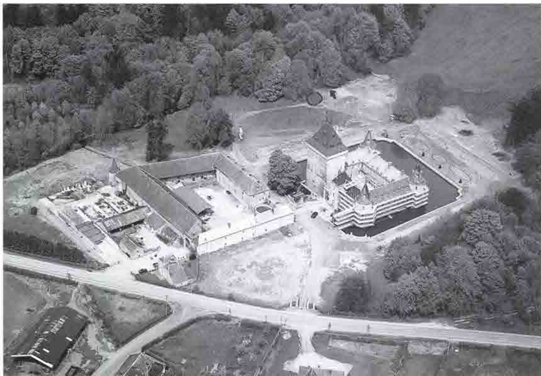
MARCHE-EN-FAMENNE - Hargimont (Jemeppe), château de Jemeppe. Cliché G. Focant, DPat, © MRW.
