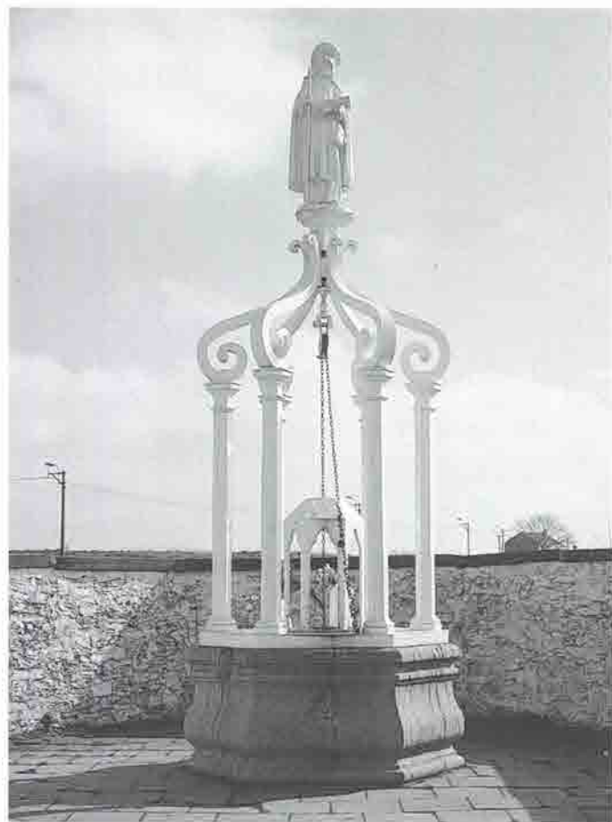
TUBIZE-Saintes, puits de Sainte-Renelde. Cliché G. Focant, DPat, © MRW.
