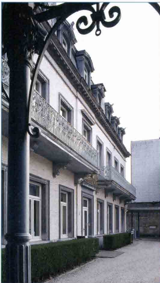
SPA / Spa, Villa Royale. Cliché G. Focant © SPW.
