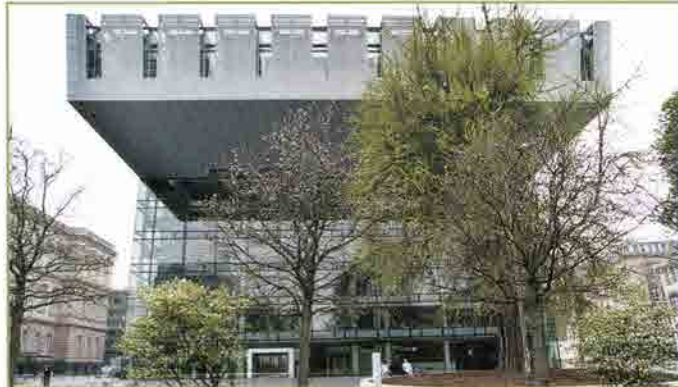
AIX-LA-CHAPELLE / Aix-la-Chapelle, Bâtiment Templergraben. © N. Kreuzsch
