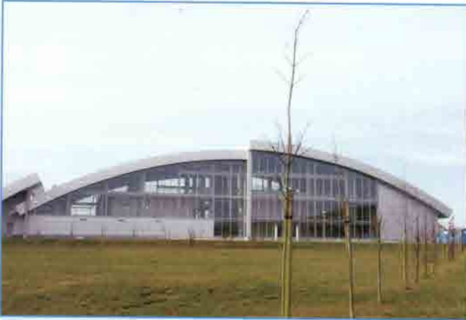
ÉCAUSSINNES / Écaussinnes. Station de potabilisation. © A. Driocq.
