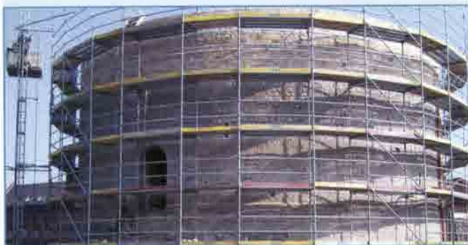
MONS / Mons. Tour Valenciennoise en chantier (2007). © D. Nihoe
