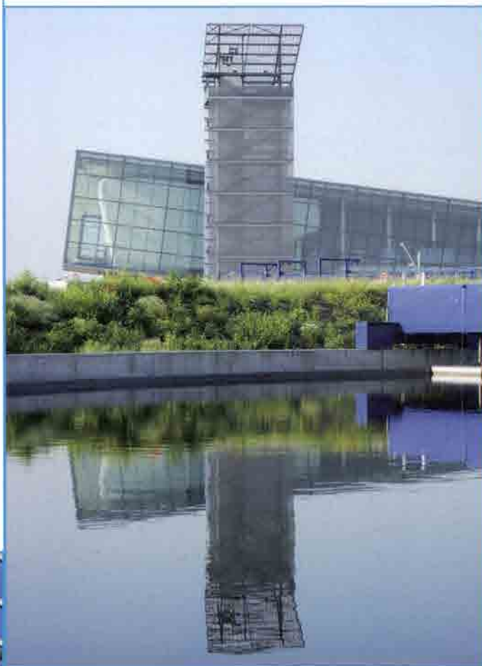
OUPEYE / Hermalle-sous-Argenteau. Station d'épuration. © A.I.D.E.
