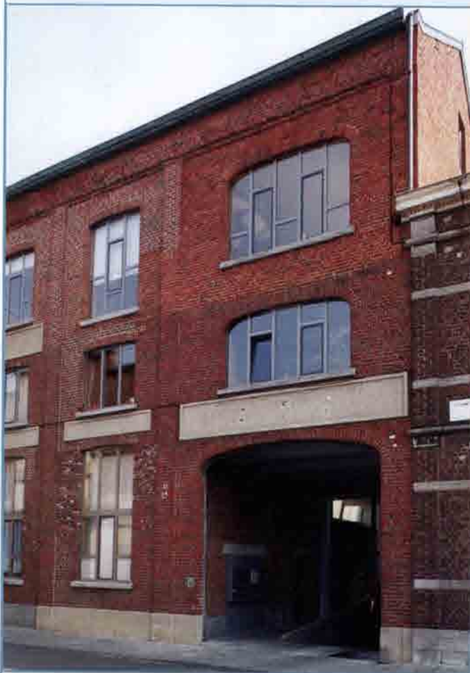
MONS / Mons. Ancienne savonnerie. Cliché G. Focant © SPW
