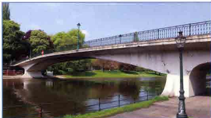
LIÈGE / Liège. Pont Hennebique. Cliché G. Focant © SPW.
