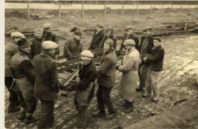
Wandre, 1942 ou 1943. Équipe de travailleurs juifs sur un chantier de l'entreprise Kinet. © Archives privées.
