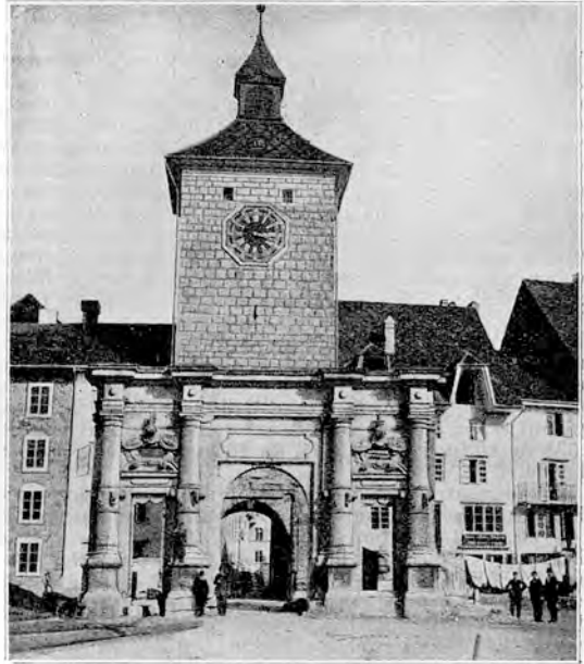
Soleure. Porte de Bienne avant sa démolition en 1872. D'après une photographie.
