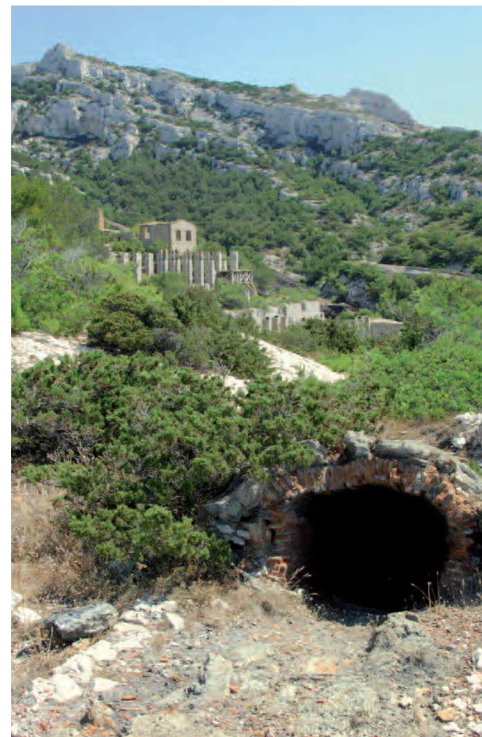
Cheminée rampante au premier plan, ruines de l'ancienne usine de plomb de l'Escalette en arrière plan © GIP des Calanques
