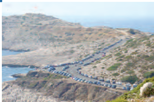
En arrière plan : remblais des travaux du métro ; en premier plan : scories polluées ; à droite : fragmentation des habitats dus à la divagation des promeneurs © GIP des Calanques
