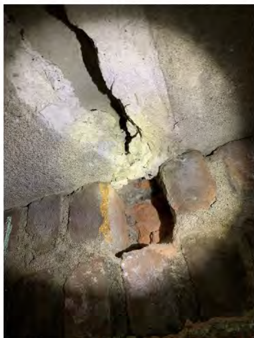
Figure 10 : Ouvertures exploratoires permettant de valider certains enfoncements de dalles préfabriquées
