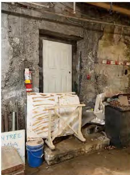
Photos 2 et 2a : Mauvaise qualité du béton autour d'anciennes ouvertures
