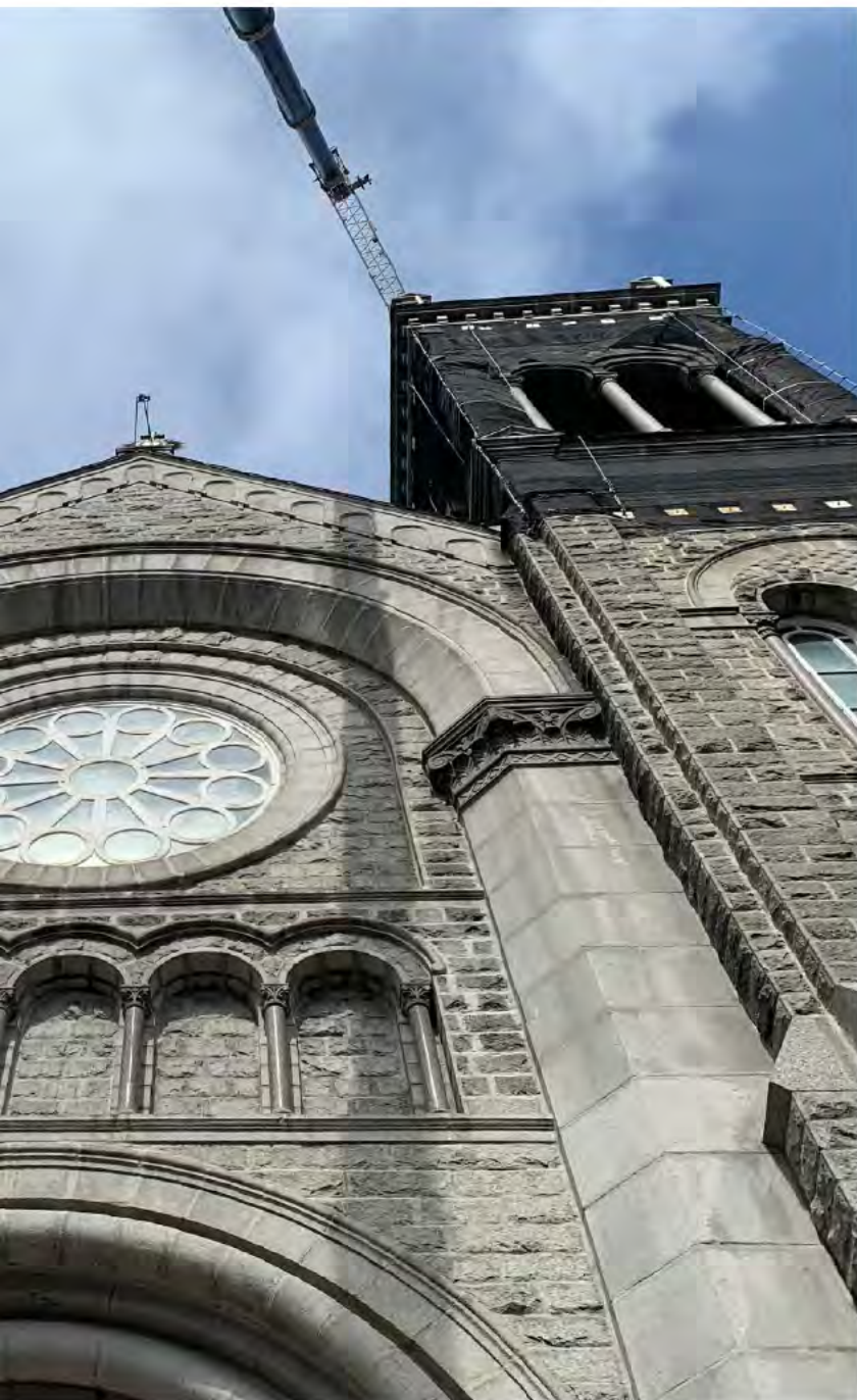
Illustration : Inspection d'une des tours
