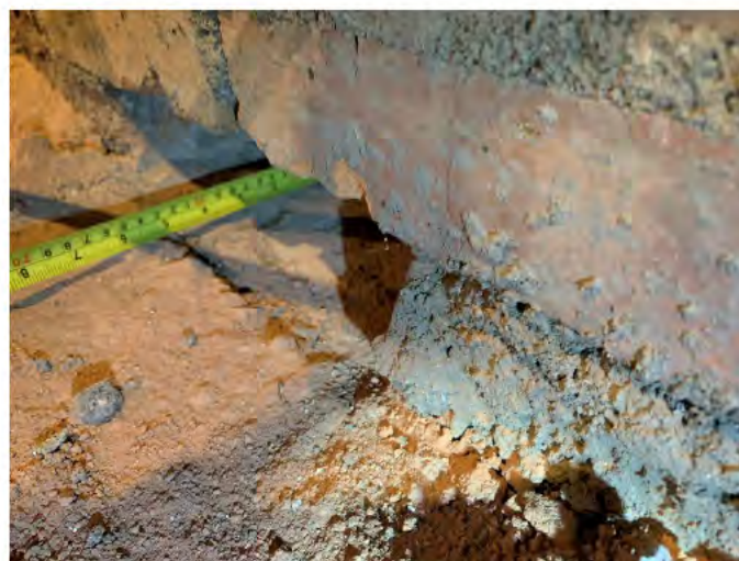
Figure 10 : Ouvertures exploratoires permettant de valider certains enfoncements de dalles préfabriquées
