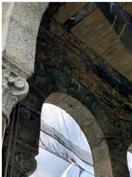
Photo 28 : Brique endommagée
