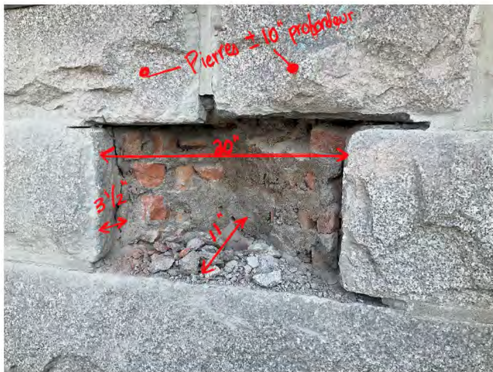
Figure 3 : Ouverture exploratoire Z1-05
