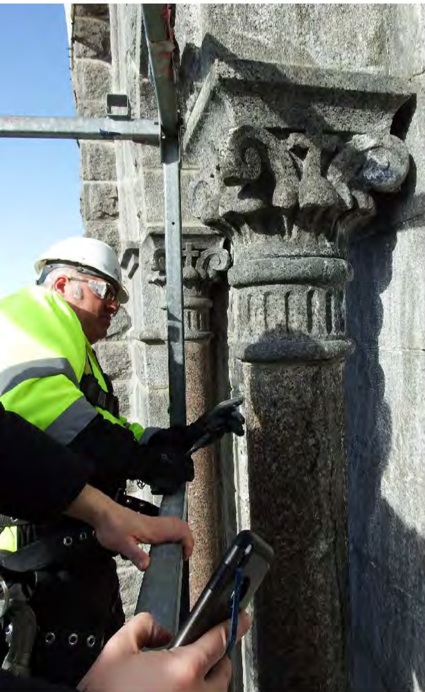
Illustration : Inspection de la maçonnerie de la façade sud
