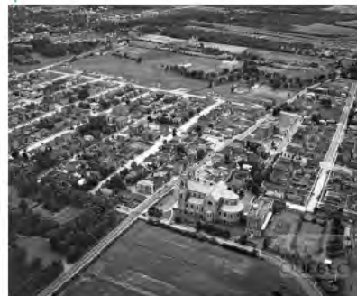
Vue aérienne du quartier Saint-Sacrement, 1949. Source : Archives de la Ville de Québec.
