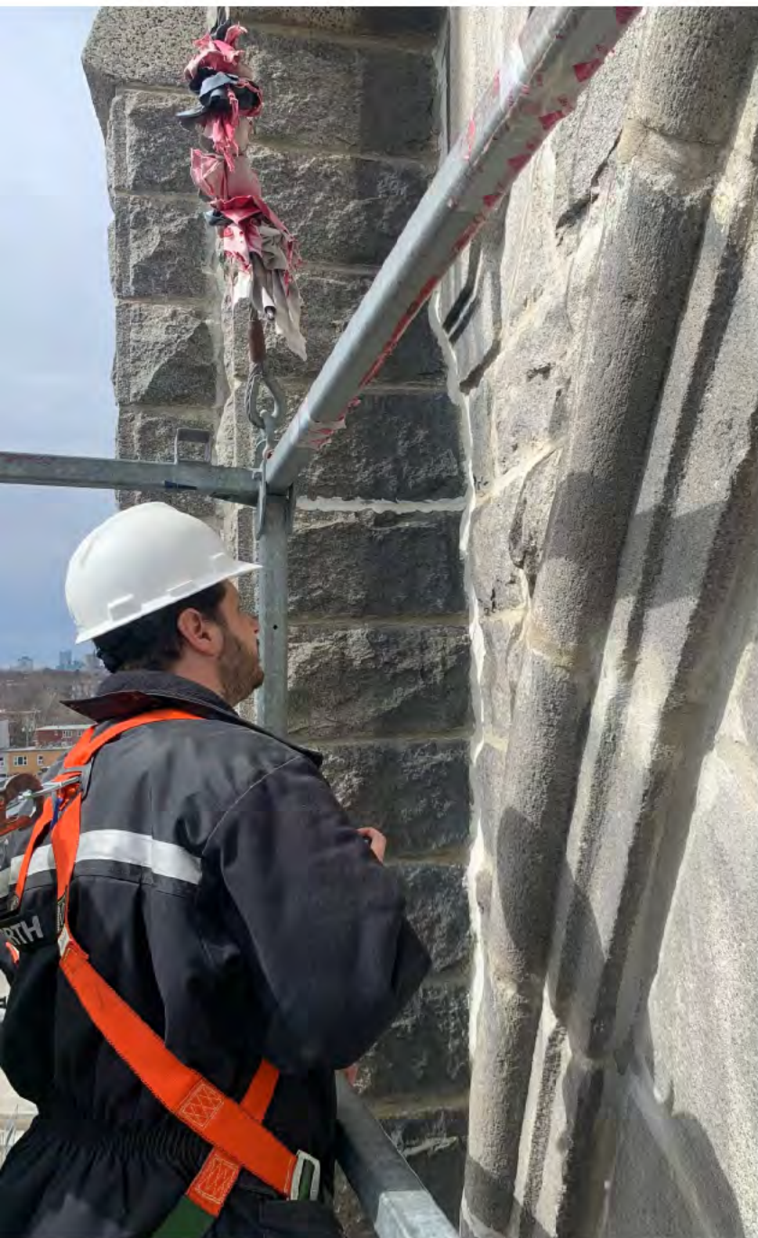
Illustration : Inspection de la façade
