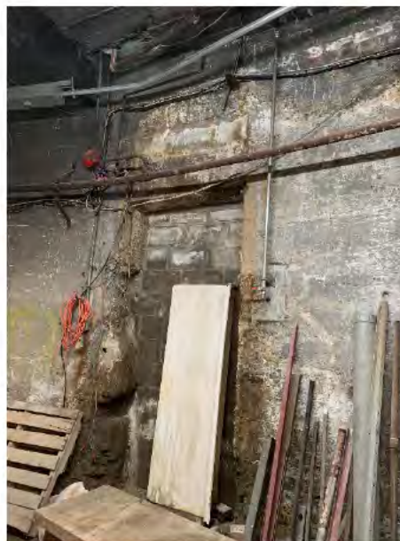
Photos 2 et 2a : Mauvaise qualité du béton autour d'anciennes ouvertures
