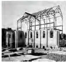
Structure en acier de l'Église du Très-Saint-Sacrement.
