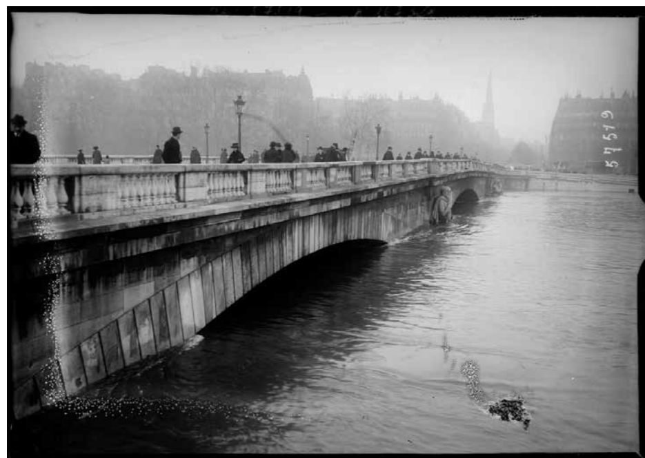
Illustration n°12 - Crue de 1924, zouave du pont de l'Alma - Source : Gallica
