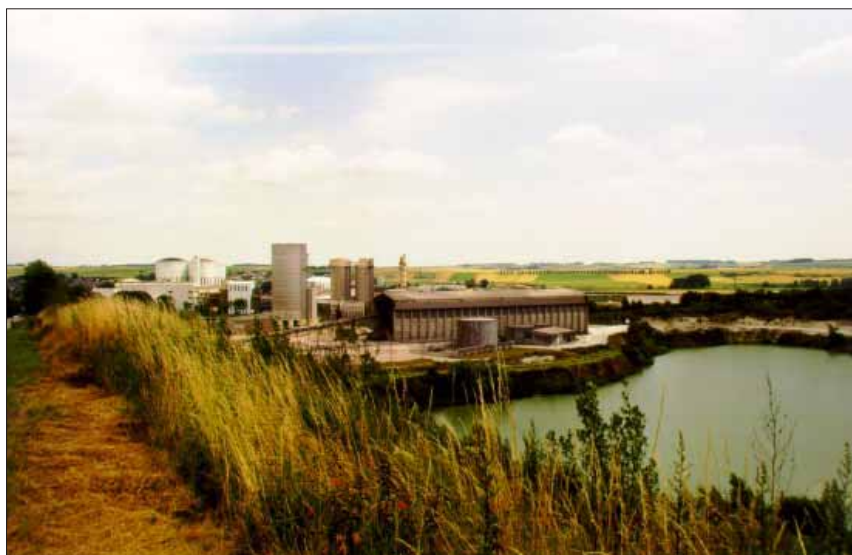
Activités industrielles : cimenterie d'Origny
