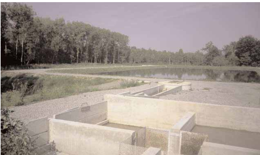
Station de lagunage de Parfondru
