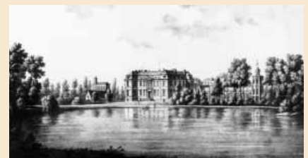
Le château de Caulaincourt
