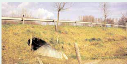
Chivy, passage sous la RN2
