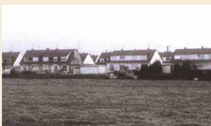
Un lotissement à l'habitat standardisé
