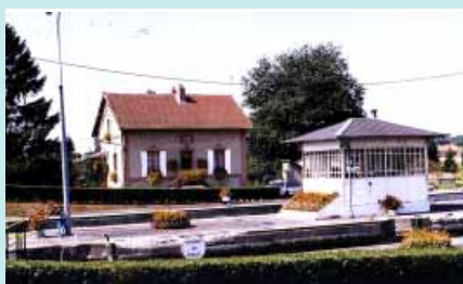
Ecluse à Mennessis : canal de l'Aisne à l'Oise
