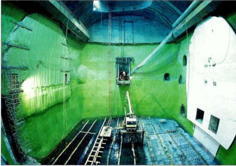
Juillet 2002: le volume de la cavité apparaît clairement, alors que l'on renforce la dalle.
