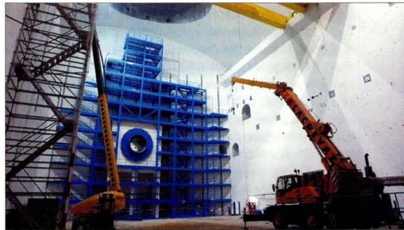
Juillet 2003: cette structure métallique de 12 étages est l'une des premières structures installées dans la caverne terminée. Des structures de ce type, qui serviront à l'accès et aux baies d'électronique, entoureront le détecteur des quatre côtés.
