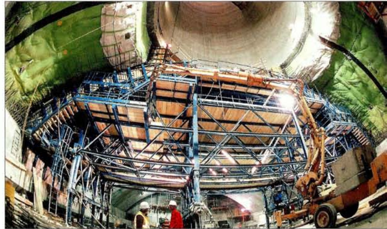
Juin 2001: la portée du hall du détecteur ATLAS (35 m) est parmi les plus longues jamais réalisées pour un ouvrage souterrain. La voûte de la caverne de 1380 m 2 est suspendue par un système de fixations ancrées dans des galeries latérales donnant sur les puits d'accès.
