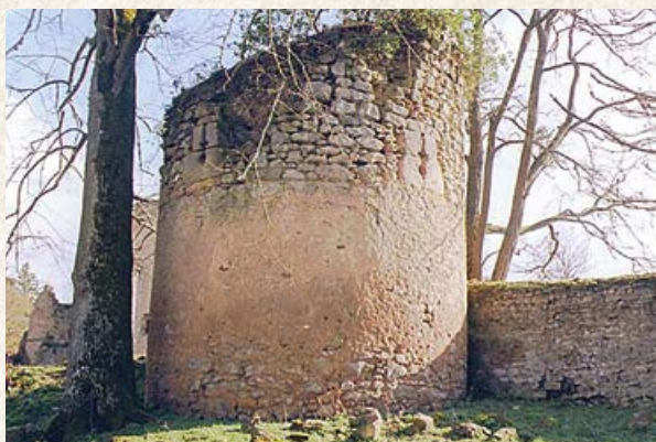
(fig. 18) La tour des commons
