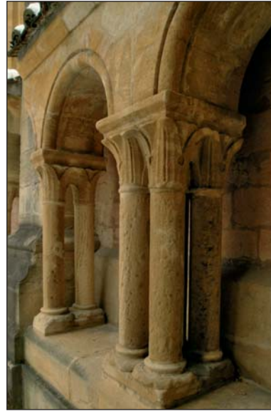
Fig. 21. Détail des anciennes arcatures du bâtiment du chapitre du XIII e siècle (Archives OPMS).
