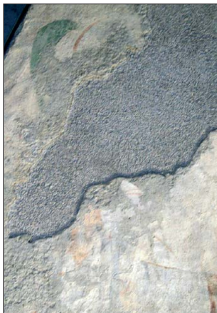
Fig. 12. Détail de la partie supérieure.
