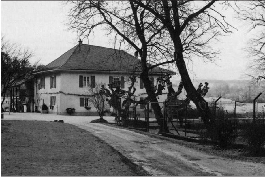
Fig. 6. La belle maison des éclusiers du canal se trouve à l'entrée nord de la cluse d'Entreroches. Un port avait été aménagé à proximité.
