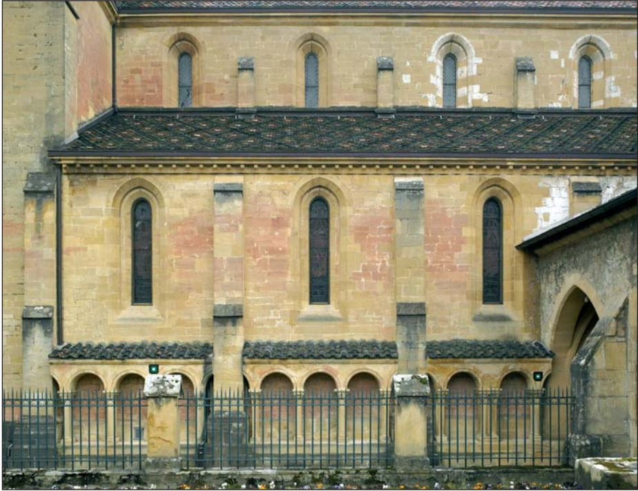
Fig. 17. Mur nord de la nef de la collégiale sur lequel on distingue les traces de la galerie du cloître du XIII e siècle (Archives OPMS).
