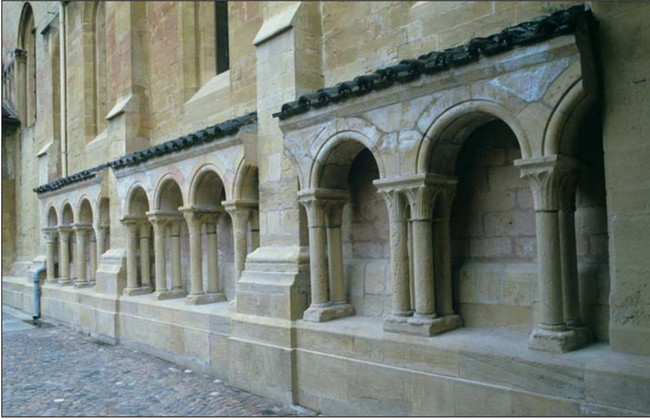
Fig. 20. Anciennes arcatures du bâtiment du chapitre du XIII e siècle remontées contre la collégiale vers 1875 (Archives OPMS).
