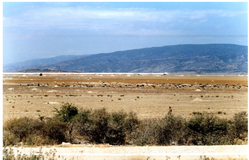
Photo 4 : Futur lac Karla, digue en construction à l’horizon © ARH 2001
