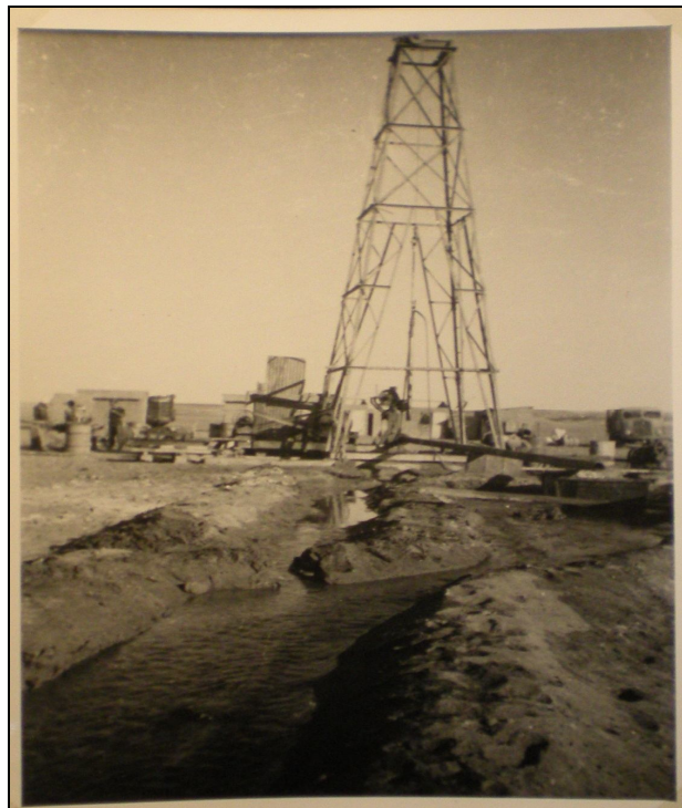
Figure 73. Un forage hydraulique finalisé à Ouenzerik, 1950
