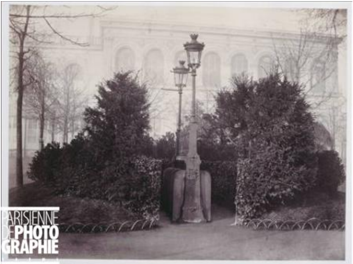
Figure 5.1 Charles Marville, “Urinal of 8 stalls, cast iron and slate, with screen of shrubbery, jardin des Champs-Élysées, around 1870. Paris (8 th arrondissement) [Urinoir à 8 stalles, fonte et ardoise, avec écran d'arbustes, jardin des Champs-Élysées, vers 1870. Paris (VIII ème arr.).” Paris, musée Carnavalet. © Charles Marville / Musée Carnavalet / Roger-Viollet (From Paris en images : http://www.parisenimages.fr/fr/popup-photo.html?photo=26215-1 )
