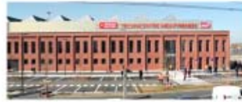
Etablissement régional de maintenance des TER à Toulouse
