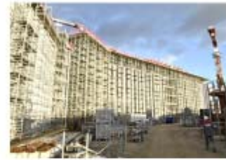
Travaux en cours : Faculté de médecine à Montpellier
