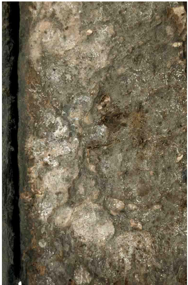
Fig.112 – Vue de la face extérieure du bordé sur laquelle on observe la présence d’un enduit.
