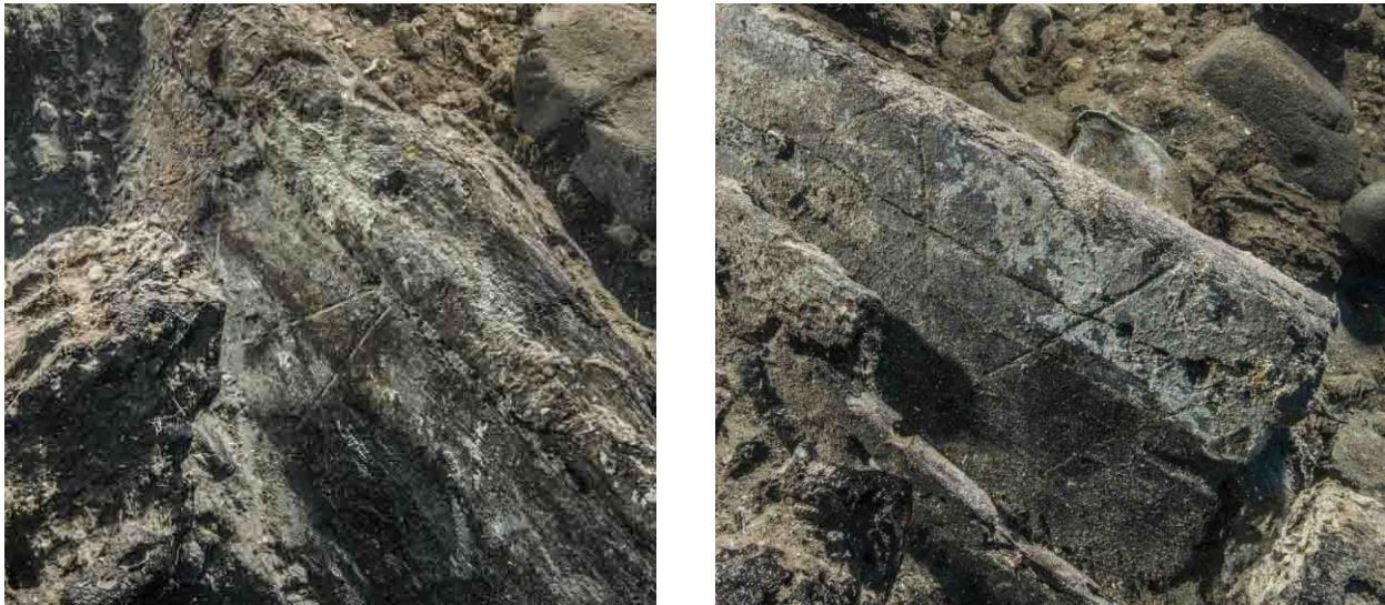
Fig.100 – Marques de charpentier en forme de VI - Photo C. Gerigk
