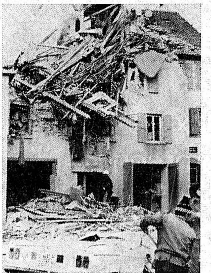
7, rue de la Chapelle, l'immeuble a explosé.
