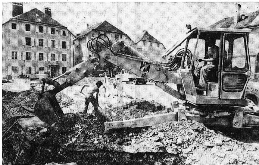
Les travaux ont débuté hier matin. Le bâtiment sera élevé au printemps 1983. (Impar-Charrère)
