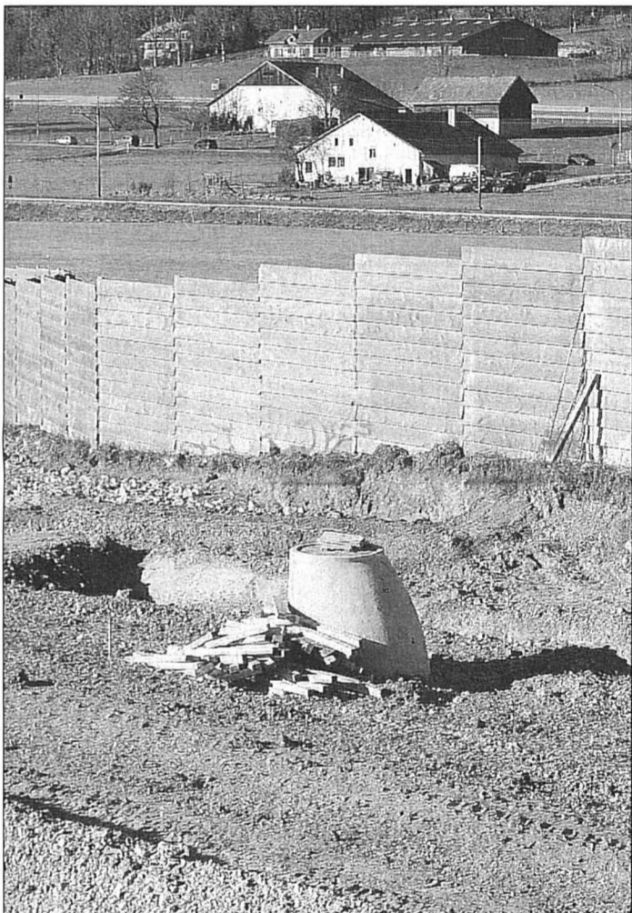
Aux Eplatures, une palissade protège la zone de marais d'importance nationale.
