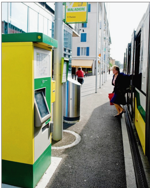
DISTRIBUTEUR Les nouvelles installations permettront de délivrer les futurs billets de la communauté tarifaire intégrale. (DAVID MARCHON)
