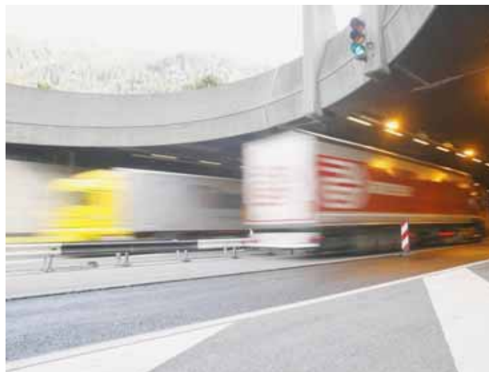
Le tunnel du Gothard doit être refait de fond en comble. Mais avant, le Conseil fédéral préconise le percement d'un second tube. KEYSTONE
