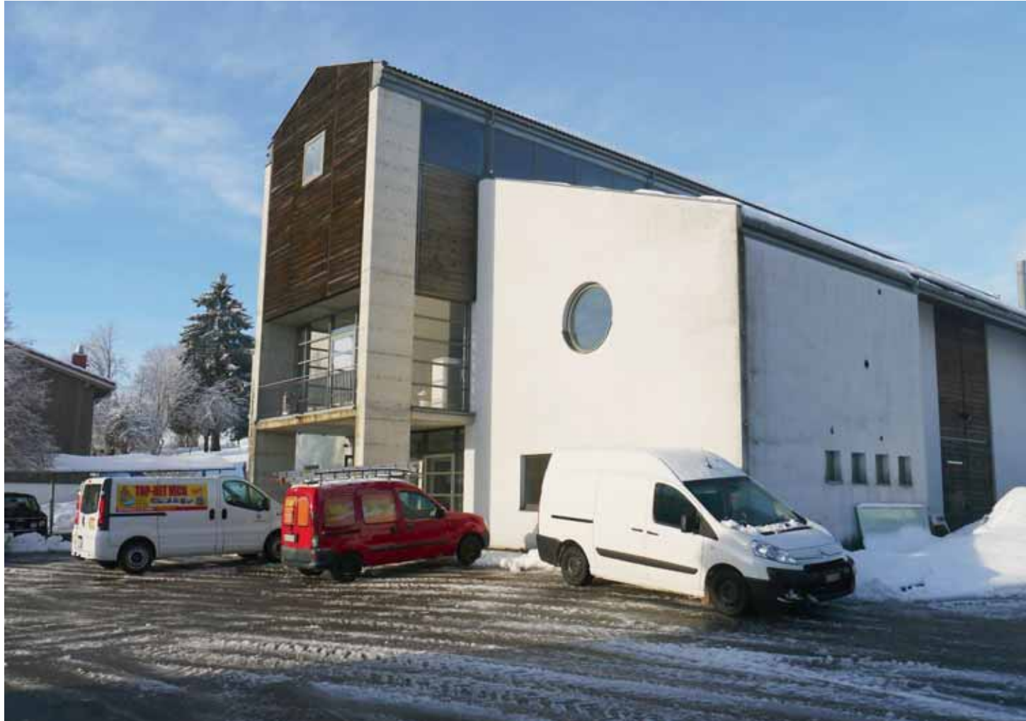
Le bâtiment de l'ancien Musée de l'automobile accueillera bientôt des machines destinées à la fabrication de spiraux et d'échappements. J. BERNHARD
