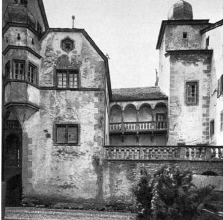
Brig | Brigue Altes Stockalperschloß [16. Jh.] Le château Stockalper La partie ancienne [XVIe siècle]
