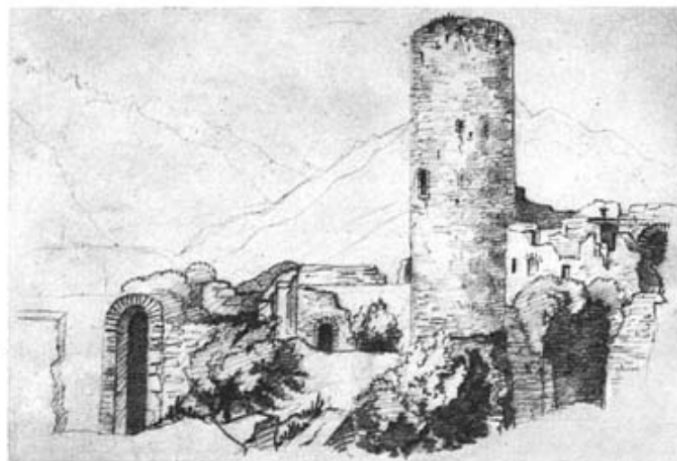
Fig. 34 Martigny-Ville. Le château de la Bâtiаз [Dessin de R. Ritz, Zurich, Musée national]
